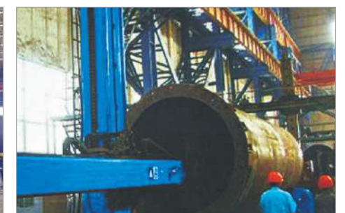
Longitudinal seam welding
