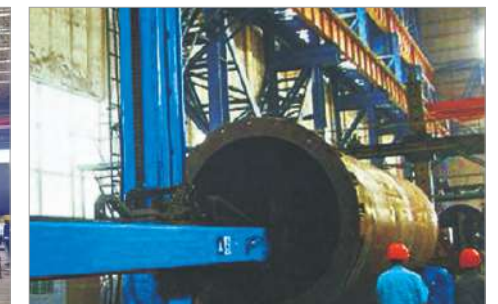
Longitudinal seam welding
