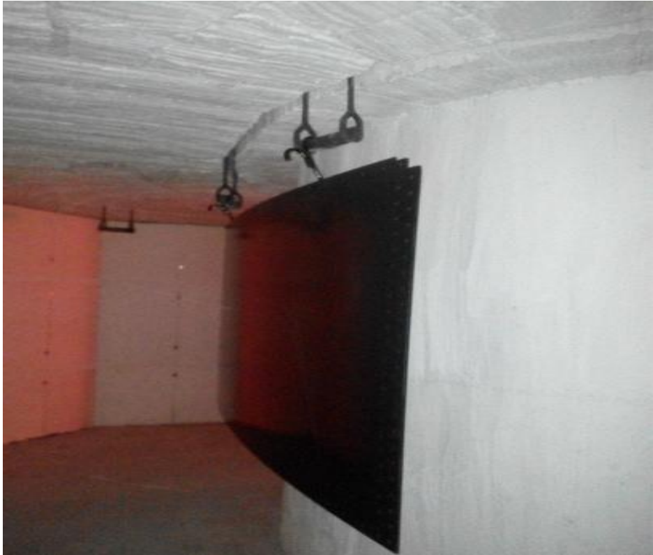
拼装罐钢板悬挂方式
