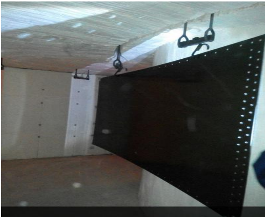
拼装罐钢板悬挂方式
