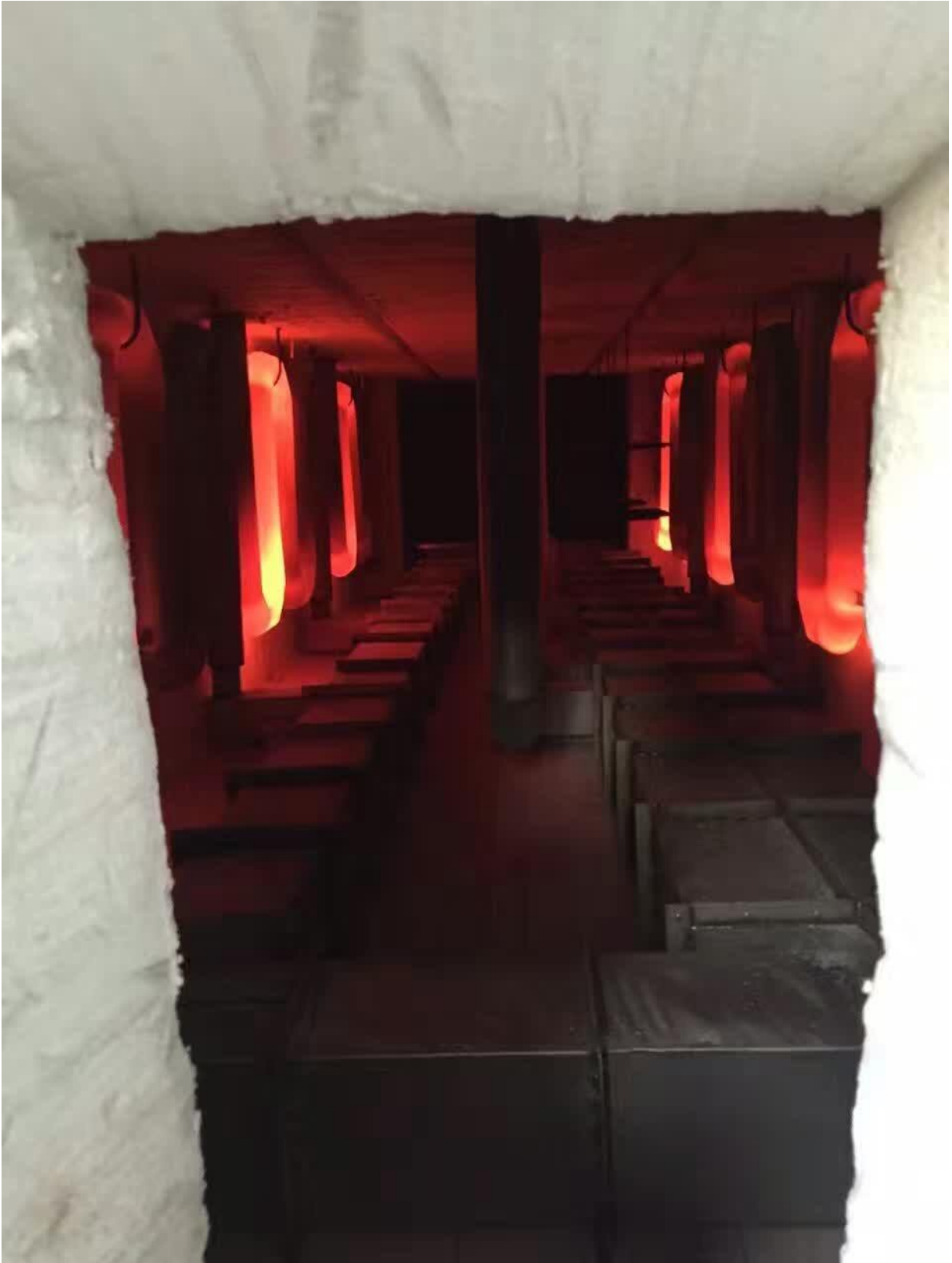
燃气炉窑实景
