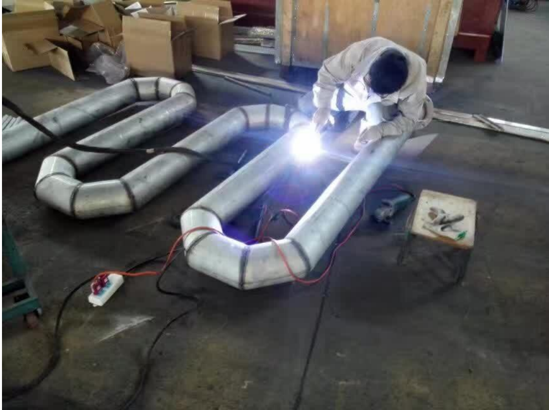
燃气辐射管制作
