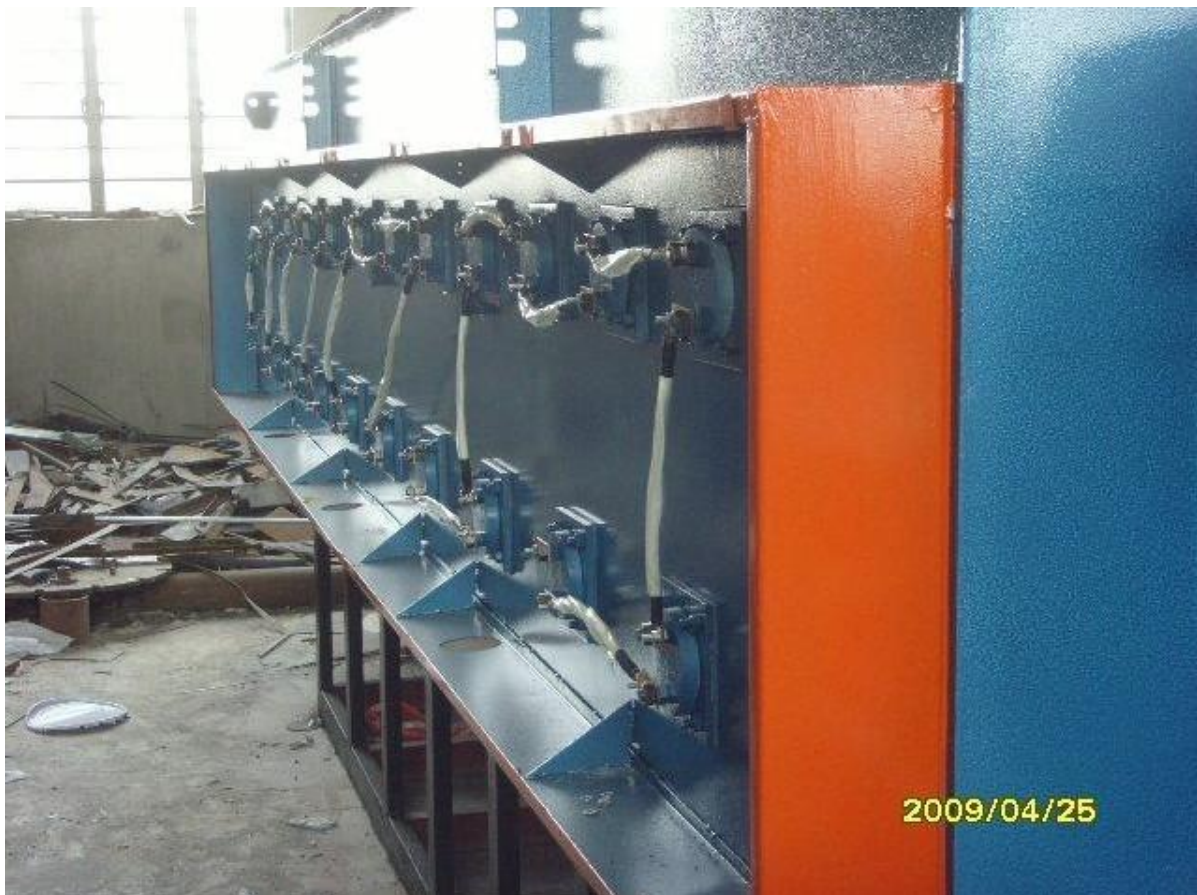
网带隧道烧结炉
