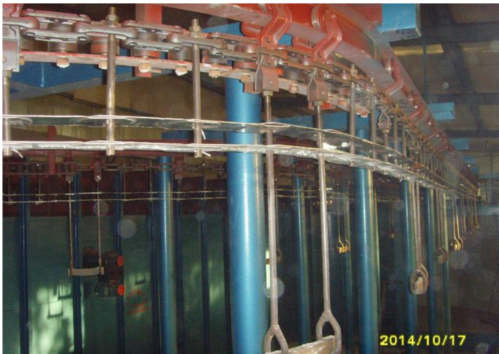
拼装罐钢板烧结生产线
