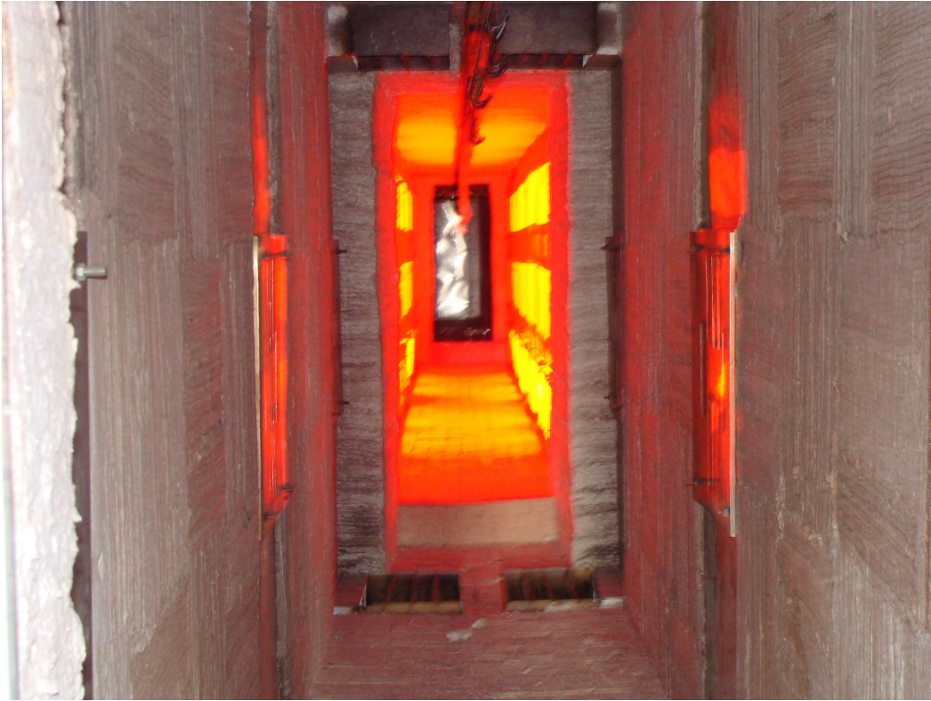
炉窑烧结实景
