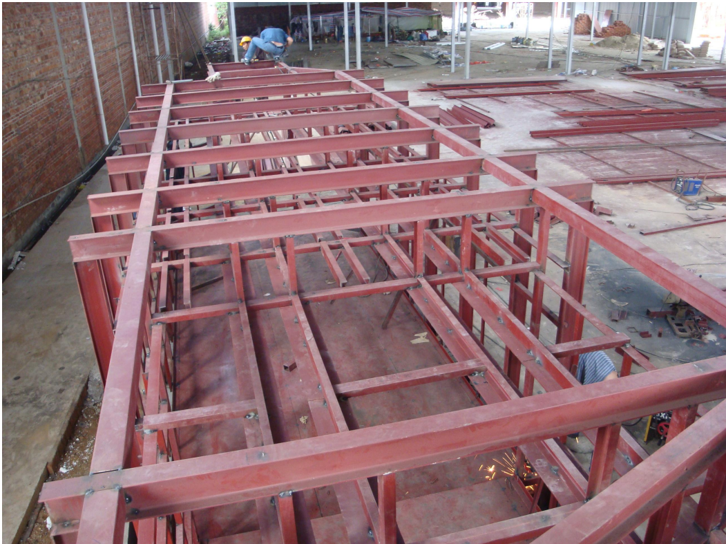
炉窑钢构现场施工
