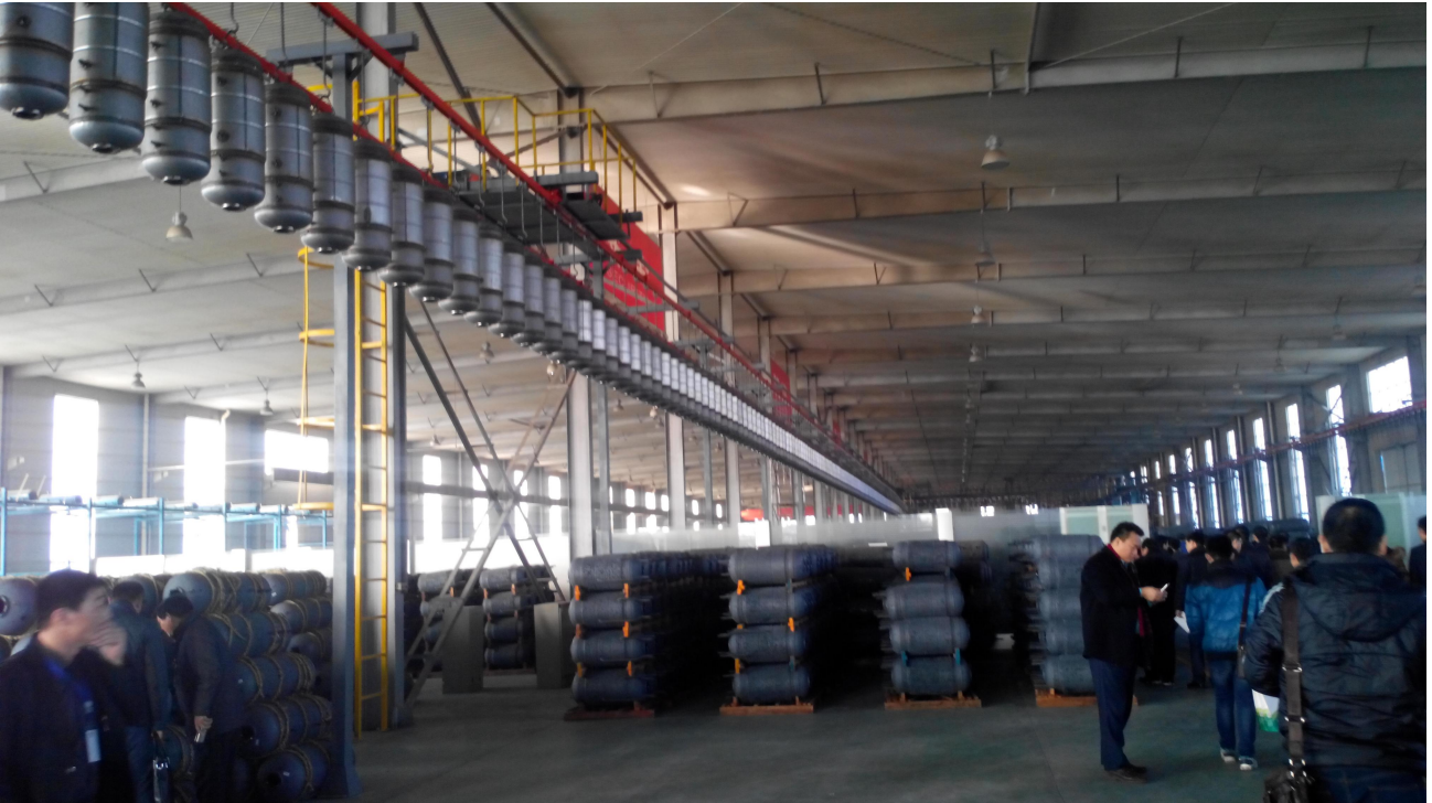
搪瓷内胆悬挂输送线
