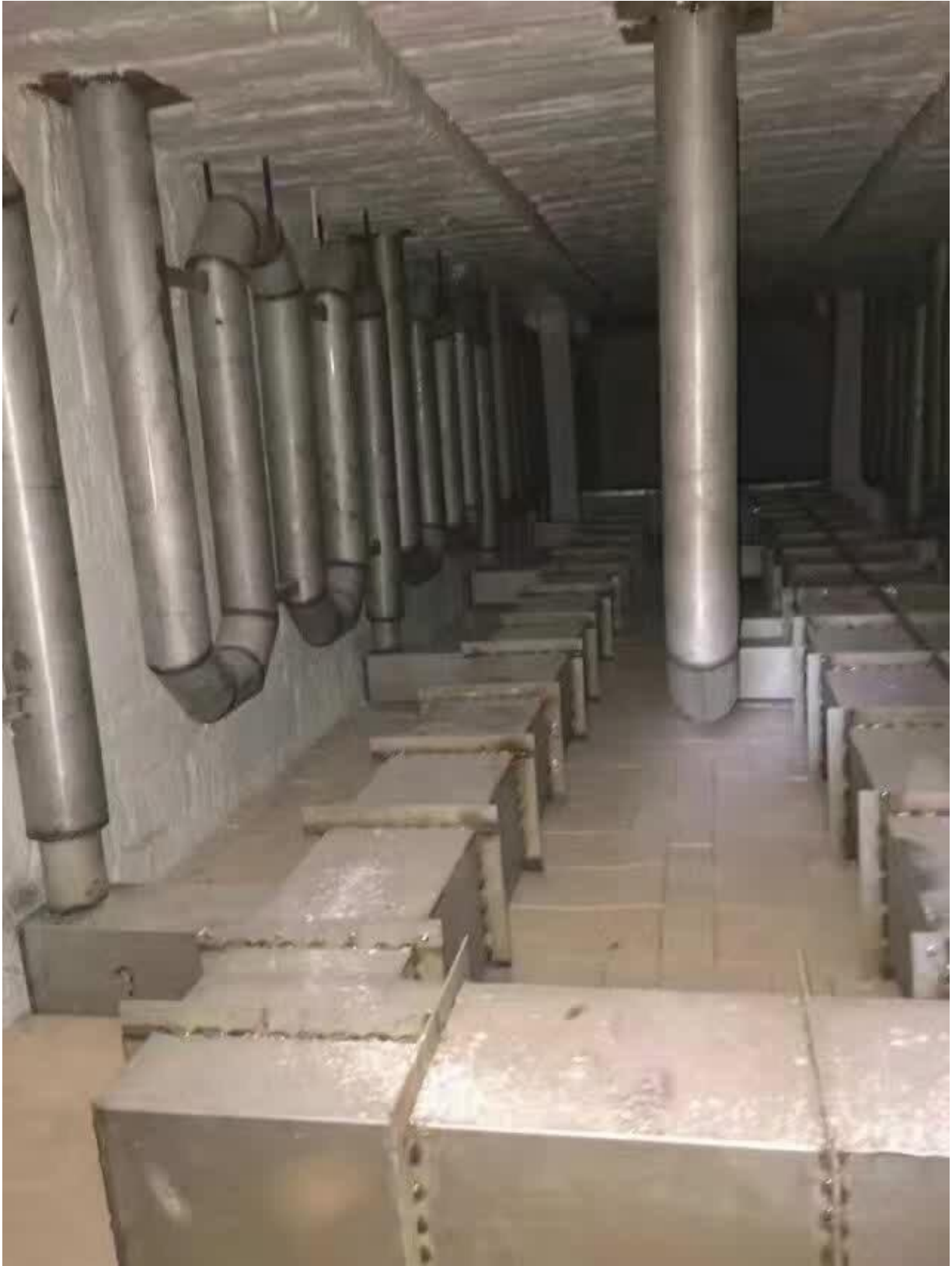
燃气辐射管安装
