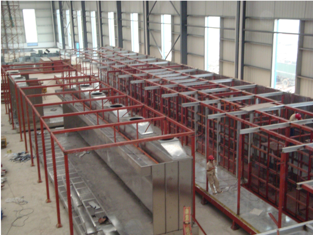
炉窑钢构现场施工
